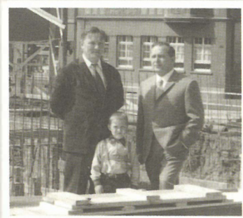
Horst Wahl (rechts) und „sein“ Architekt Willi Kölsch. Einige ihrer Neubauten wurden auf Zigarettenschachteln geplant
